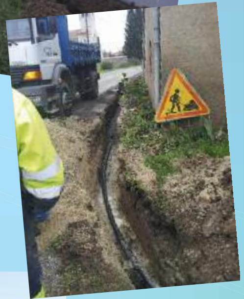
Installation des canalisations de refoulement
