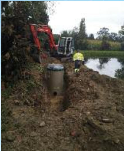
Mise en place de la station de relevage près des lagunes « Cheflieu »
