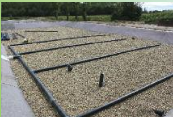
Mise en place de la couche drainante de fond et des tuyaux d'aspersion
