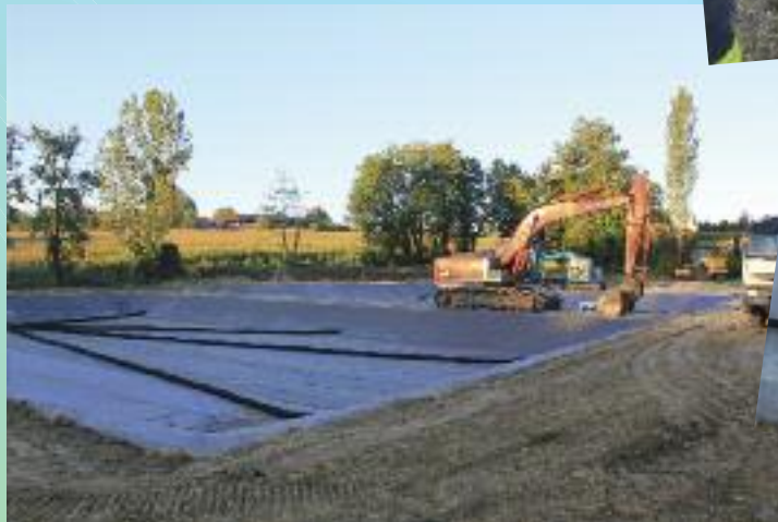
Terrassement des formes de bassin et mise en place de l'étanchéité et des tuyaux de collecte
