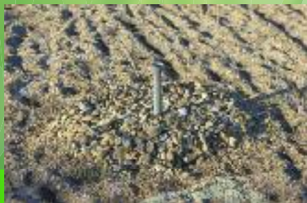
Mise en place de la couche drainante de fond et des tuyaux d'aspersion
