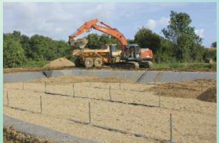
Remplissage avec les différentes tailles de graviers
