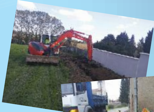
Installation des canalisations de refoulement
