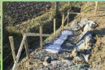
Mise en place de la couche drainante de fond et des tuyaux d'aspersion
